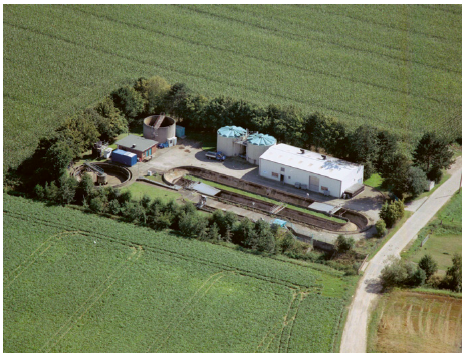
Luftaufnahme Kläranlage Titz-Rödingen (2005)
