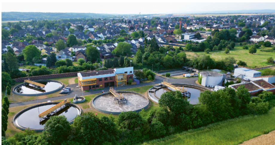
Luftaufnahme der Kläranlage Weilerswist
