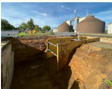
oben: Arbeiten an der Bodenplatte der Membranfiltration unten: Baugrube für die Feinsiebanlage
