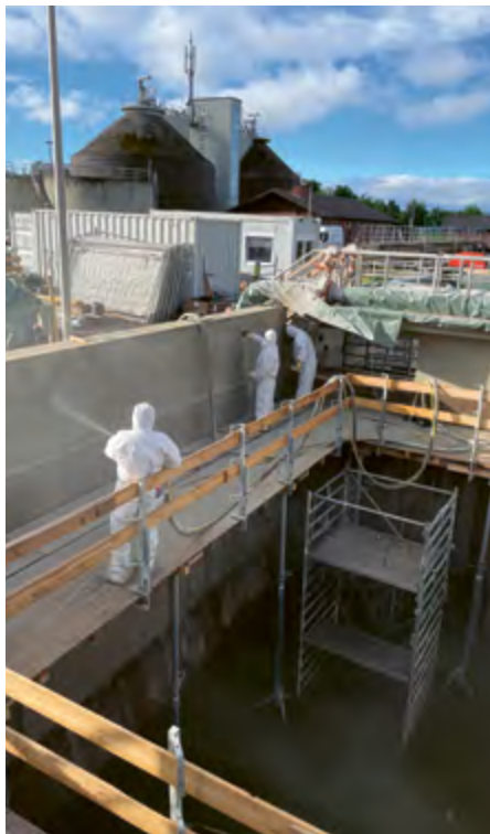
links: Sanierung der alten Belebungsbecken rechts: Betonsägeblatt zum Abbruch der Bedienstege
