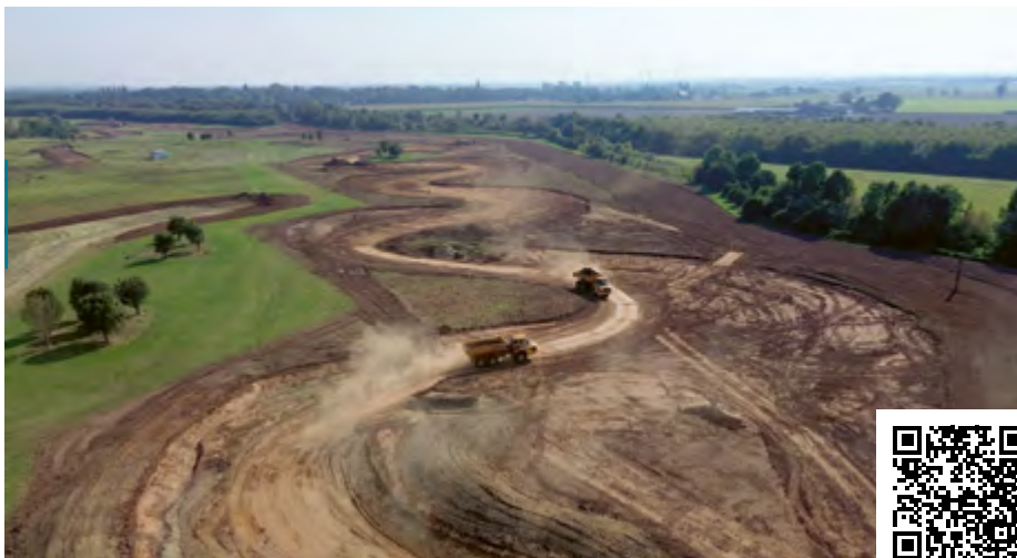
Erdarbeiten Mitte September 2024 auf der Weidefläche in der Erftaue
