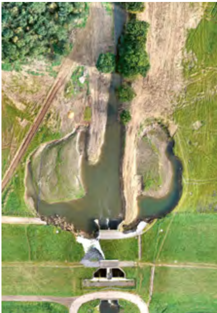
Luftaufnahme des HRB Horchheim 2021
