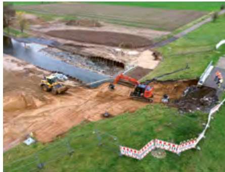
Bauarbeiten am Tosbecken und Damm im August 2023
