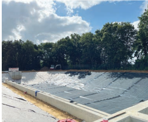
In der Bauphase
